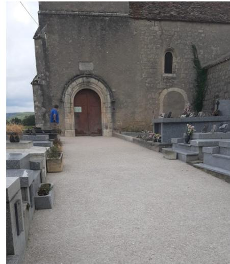
Afin de faciliter l'accès à l'église, un cheminement en béton désactivé a été réalisé en remplacement de l'allée principale en gravier. D'autres travaux sont également prévus cet hiver, comme la remise aux normes du tableau électrique, la réfection de la porte de l'église particulièrement abîmée et la peinture de la grille d'entrée du cimetière.
